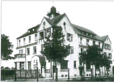
Kasino, Bild: Archiv der Thyssen Krupp AG Duisburg.
