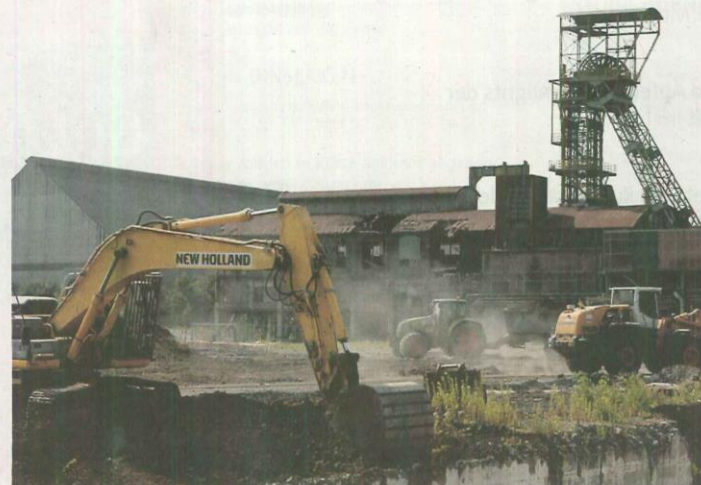
Den Blick auf die Baustelle ermöglicht jederzeit eine Webcam.
